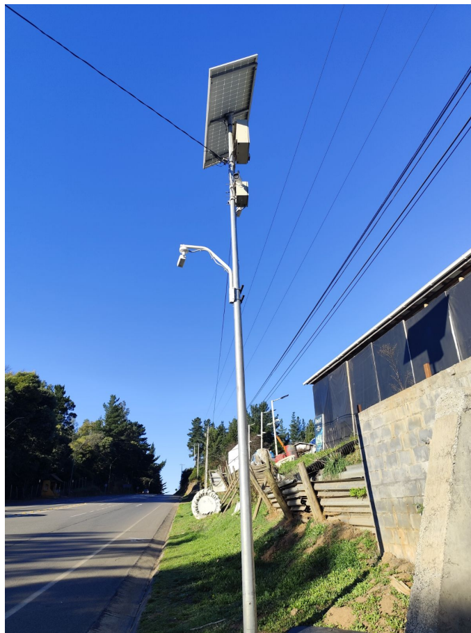
Punto operativo con panel solar, gabinete y cámaras en servicio
