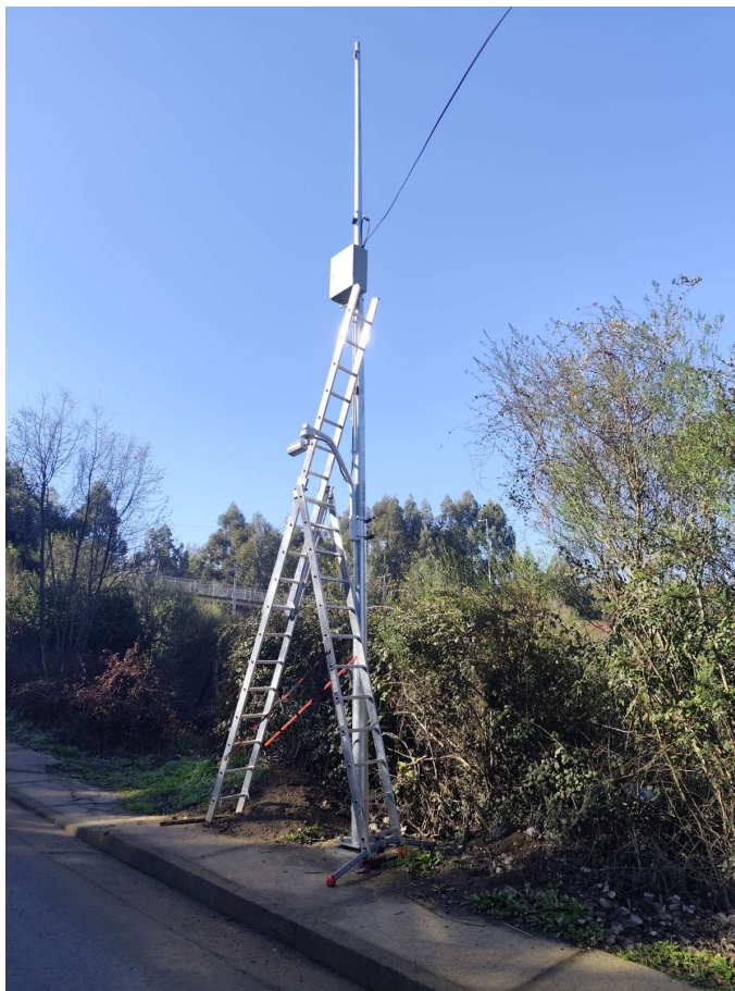
Instalación de la cámara y la caja de conexiones en el poste
